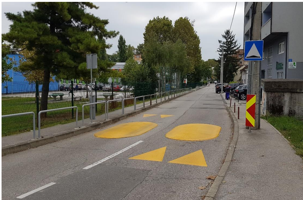
Slika 34. Novopostavljena uzdignuta ploha na Novoj cesti
