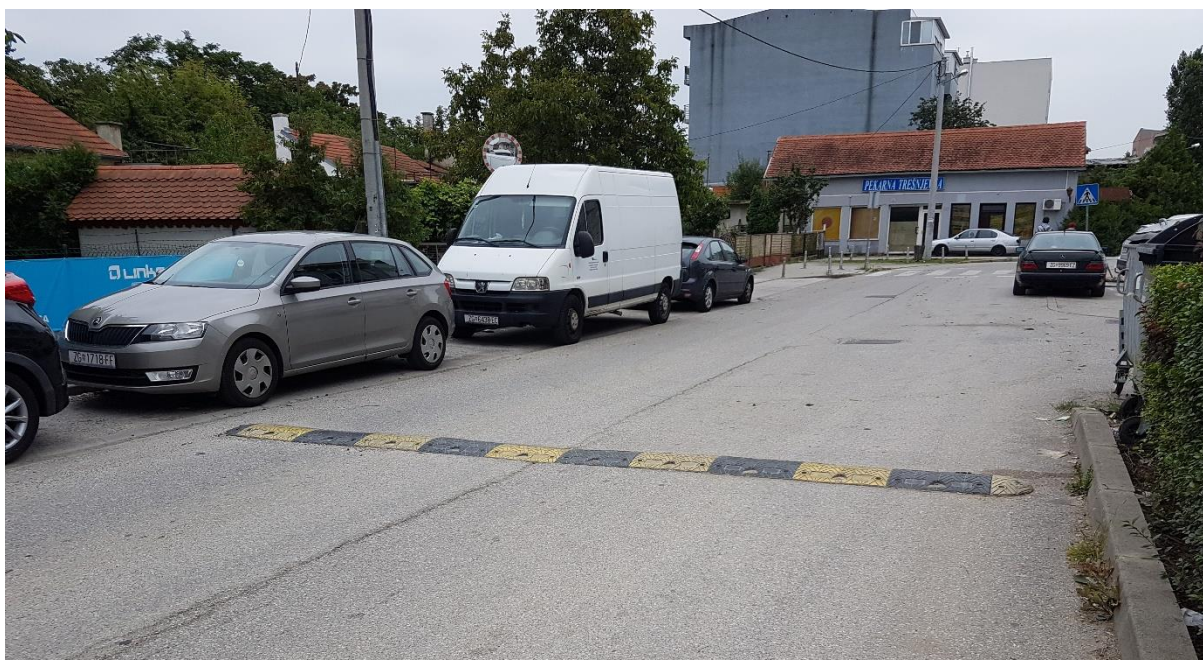
Slika 30. Umjetna izbočina postavljena u Dobojskoj ulici
