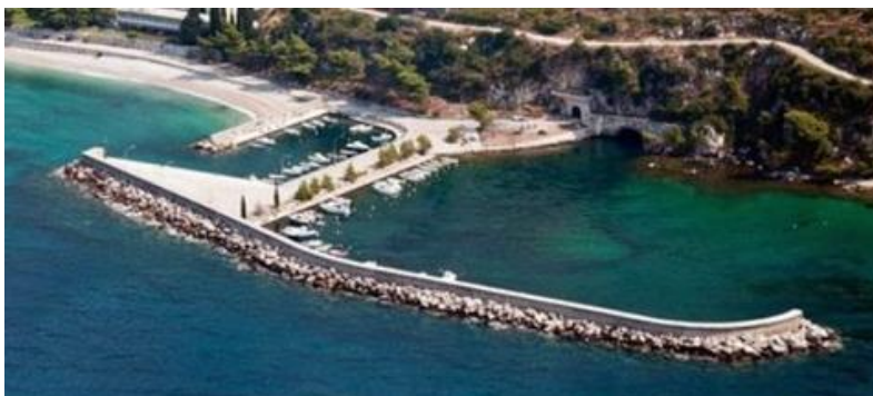
Slika 19: Mokri vez zaštićen lukobranom.
