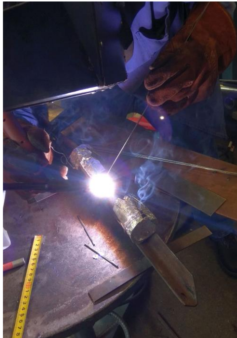
Slika 33. Zavarivanje cijevi od čelika P91
