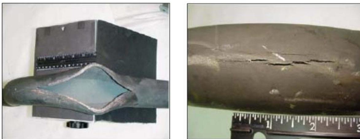
Slika 16. Pukotine na cijevima pregrijača izrađenim od čelika P91 [16]
