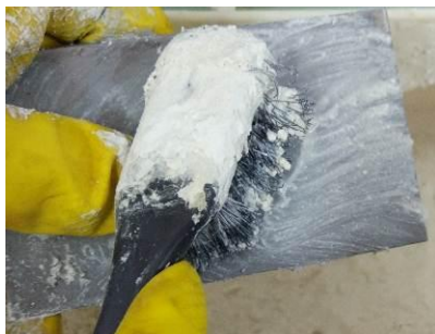
Slika 43. Prikaz provedbe odmašćivanja
