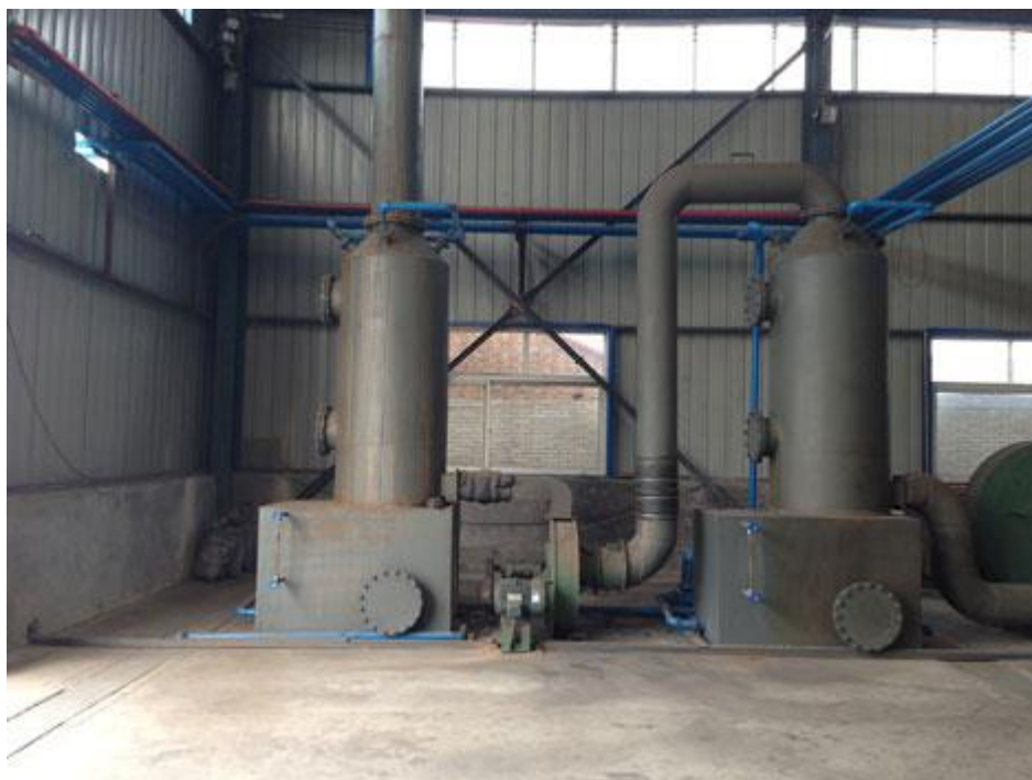
Slika 21. Sustav za otklanjanje čestica [23]
