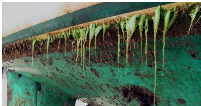
Slika 9. Obraštaj algama i balanidima [16]
