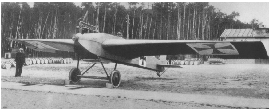
Slika 2. Junkers J-1 prvi avion potpuno metalne konstrukcije
