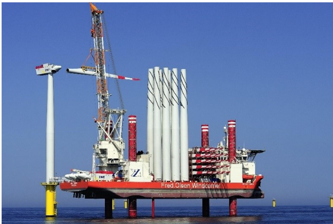
Slika 8. Postavljanje vjetroturbine na moru
