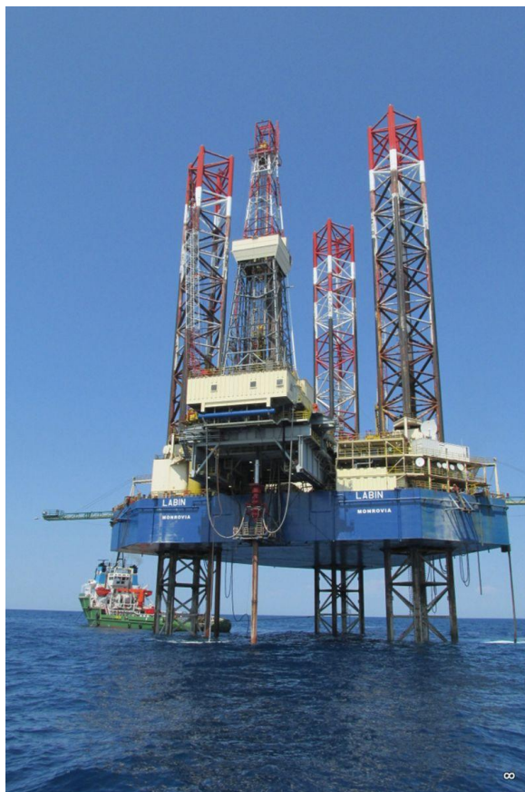
Slika 22. Samopodizna platforma Levingston 111 C
