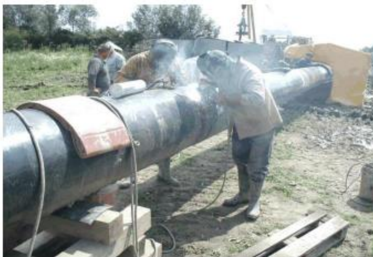
Slika 29. REL zavarivanje čeličnih cijevi celuloznom elektrodom [19]
