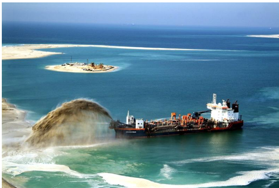
Slika 3 Iskrcaj tehnikom naštrcavanja
