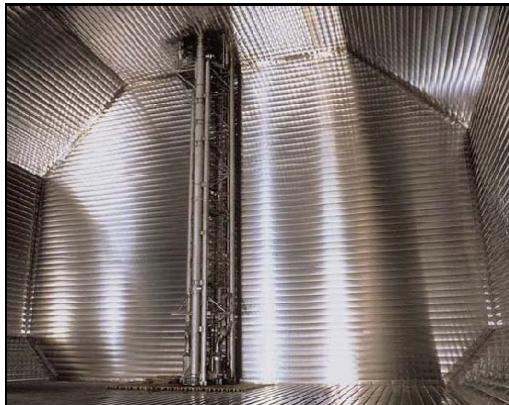
Slika 2.12. Pumpni toranj u LNG tanku [8]
