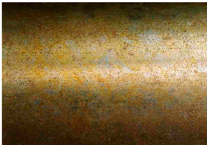
Slika 5. Primjeri galvanske korozije [15]
