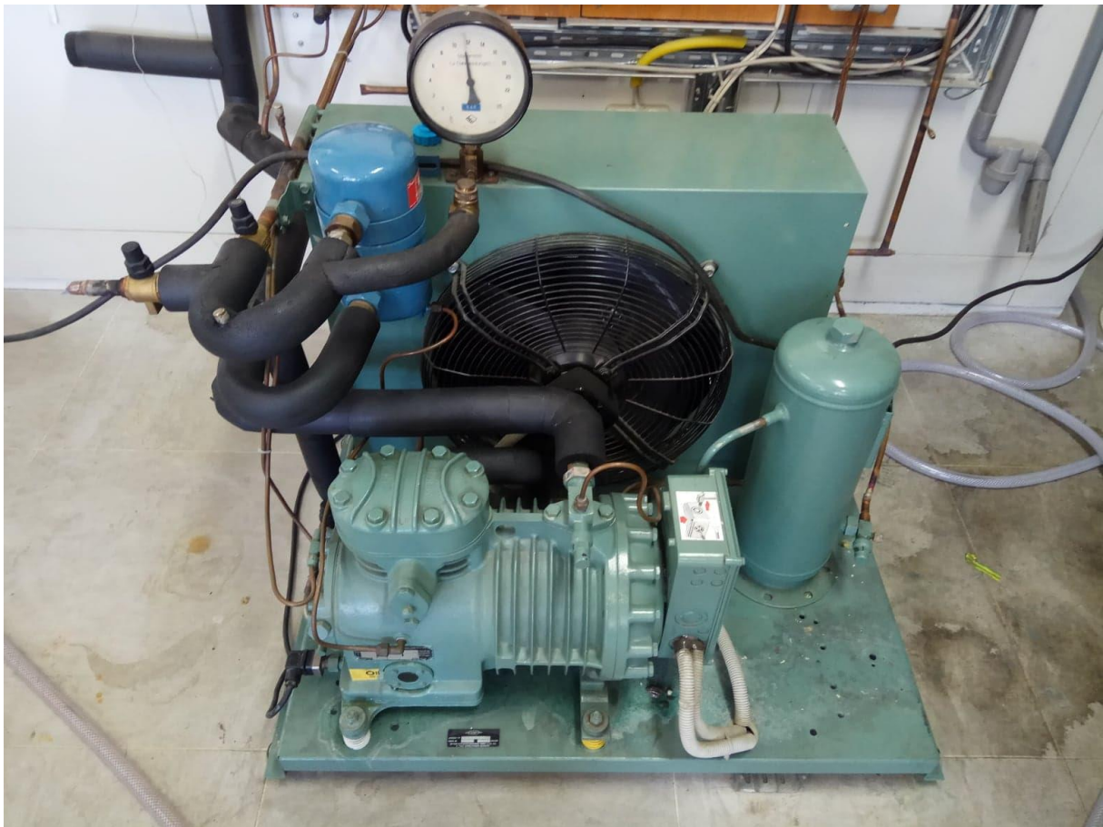
Slika 6. Kondenzacijska jedinica Bitzer LH64/2U-3.2Y
