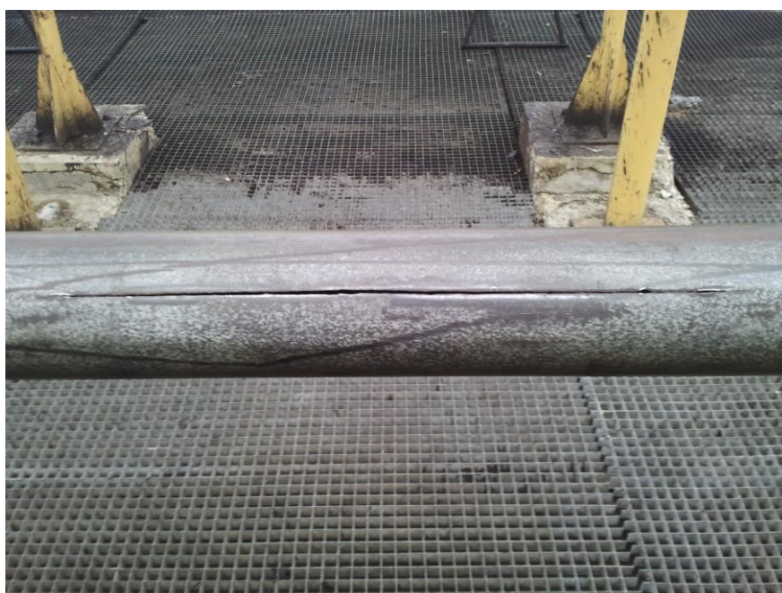
Slika 5. Primjer oštećenja na crpnoj cijevi uzrokovano trenjem šipke, vanjsko puknuće (naftno polje Žutica)
