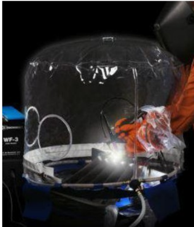
Slika 11. Izvođenje postupka zavarivanja u komori za zavarivanje [12]
