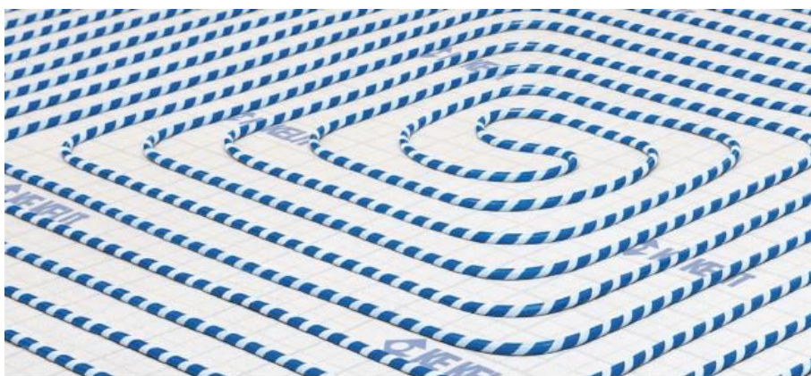
Slika 6. Postavljanje cijevi obložene čičak trakom
