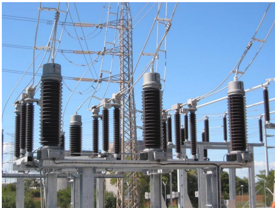
Slika 6. Mjerni transformator
