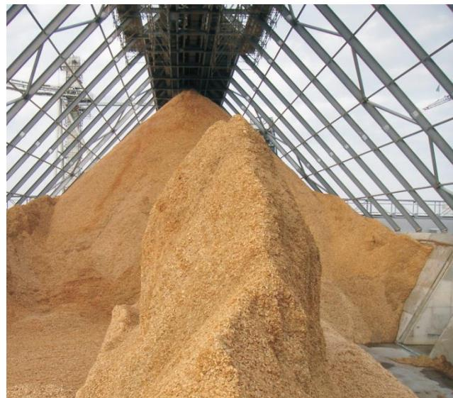
**Slika 7. Primjer skladišta drvne sječke konstruiranog u tvrtki iNGENIEURBÜRO DANNENBERG GmbH & Co. KG [13]**
