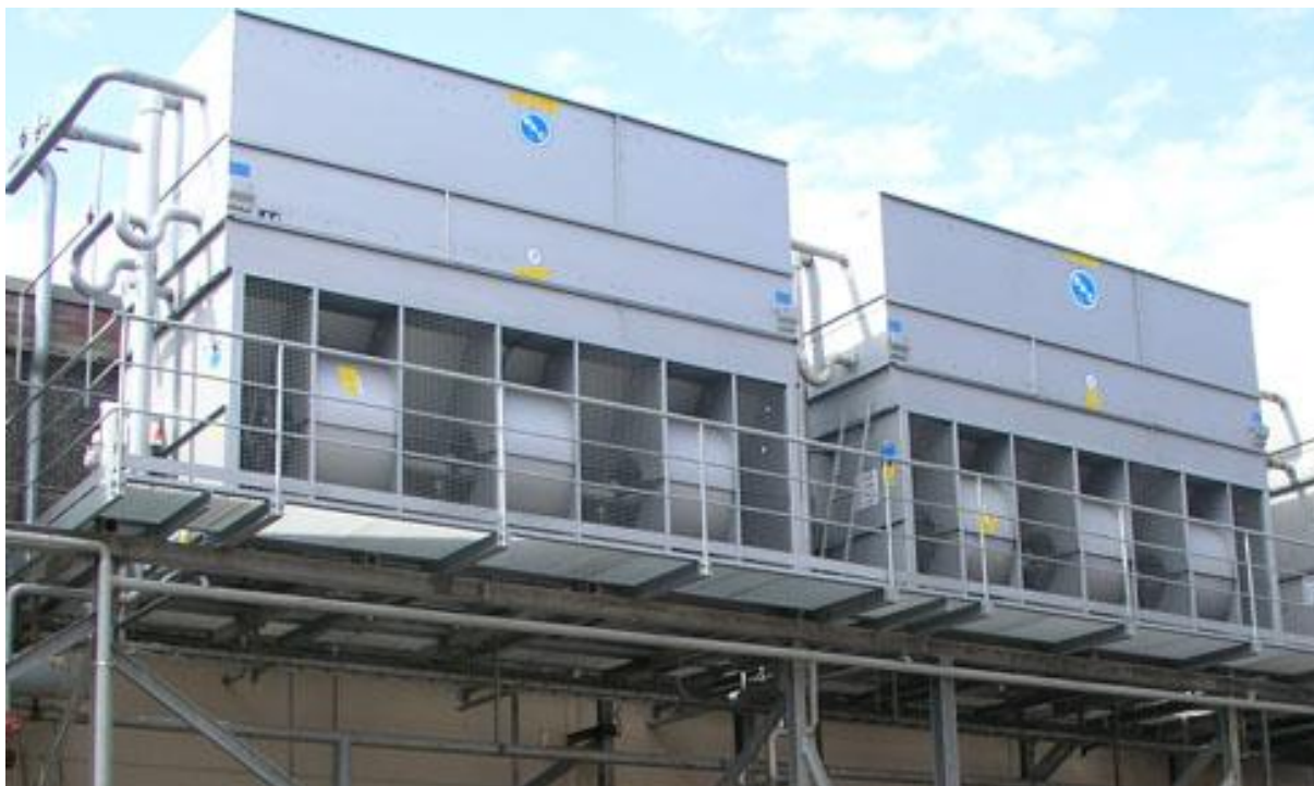
Slika 6. Evaporativni kondenzator tvrtke „Baltimore aircoil“ [7]
