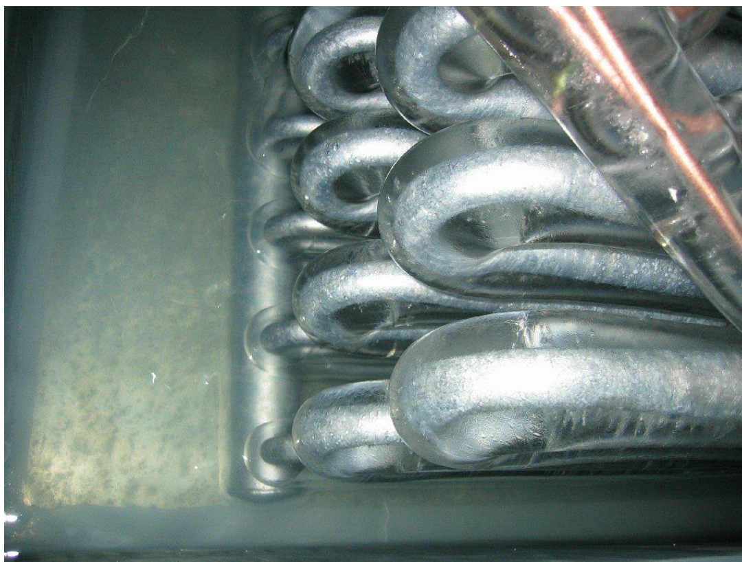
Slika 3. Led oko cijevi u banci leda [5]
