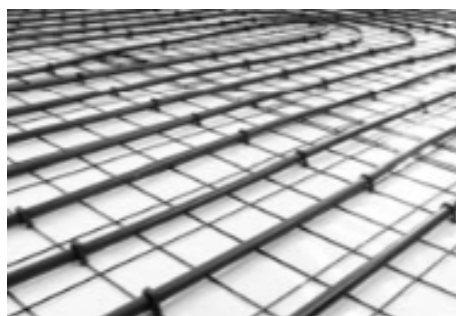
Slika 8. Podno grijanje s rešetkastom konstrukcijom [4]
