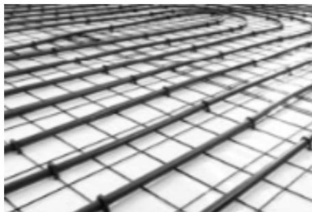
Slika 8. Podno grijanje s rešetkastom konstrukcijom [4]
