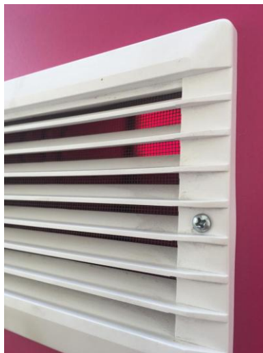
Slika 15. Zaštita od kiše na vratima punionice
