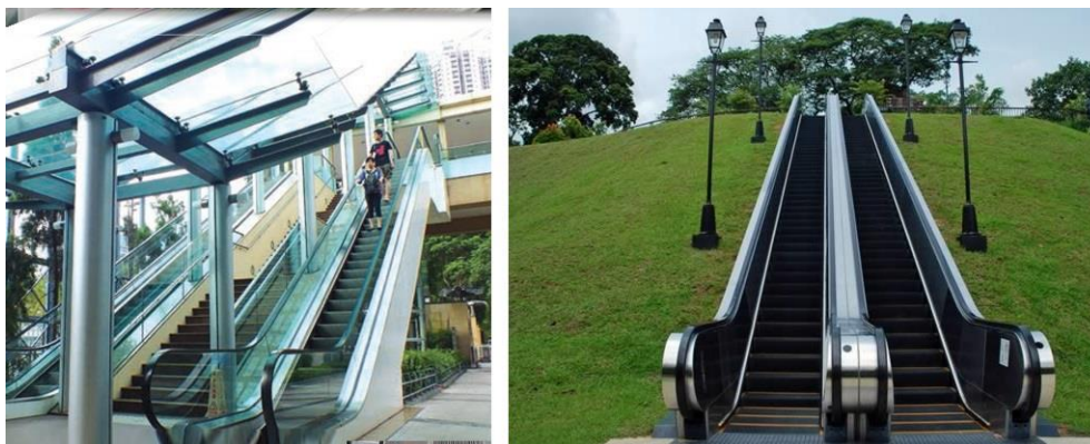
Slika 2. Polu-vanjska i potpuno vanjska izvedba pokretnih stepenica [3],[4]
