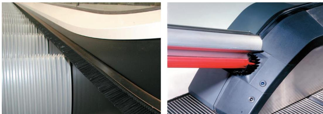
**Slika 41. Sigurnosne četke duž obruba i pri ulazu rukohvata u kućište [23]**
