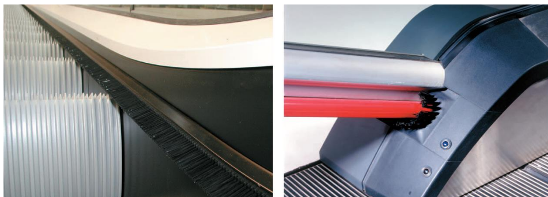
Slika 41. Sigurnosne četke duž obruba i pri ulazu rukohvata u kućište [23]
