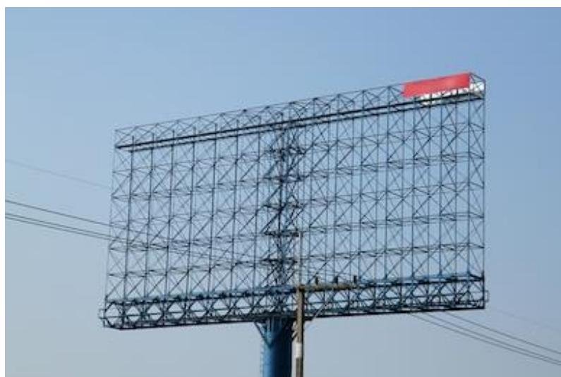
Slika 3. Rešetkasta nosiva konstrukcija bez torzijske cijevi [6]
