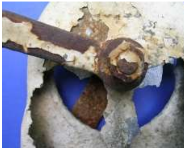
Slika 22. Galvanska korozija; stezni zatvarač čije je kućište izrađeno od aluminijske legure u kontaktu s ugljičnim čelikom od kojeg je izrađen stezni element na konstrukciji broda [8]
