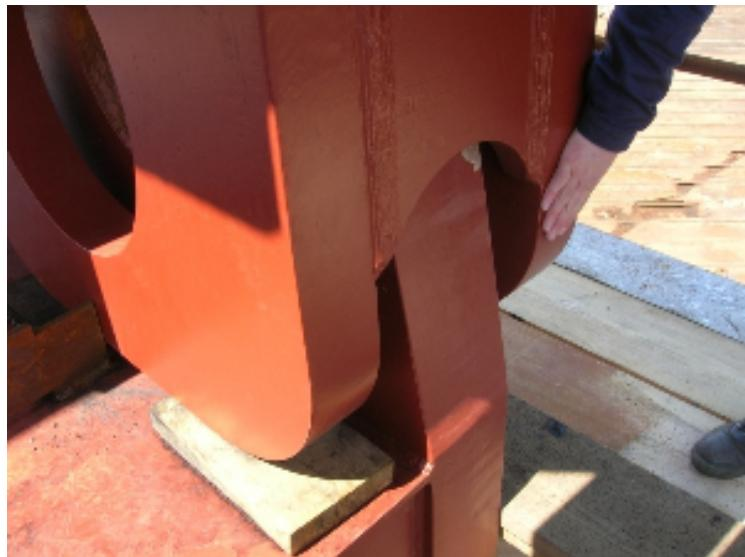
Slika 54. Dio sekcija nosača pilona debljine lima 200 mm
