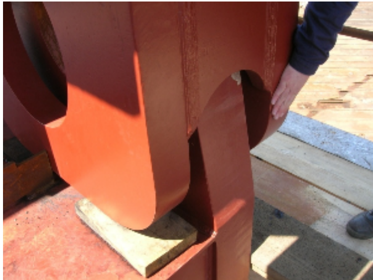
Slika 54. Dio sekcija nosača pilona debljine lima 200 mm
