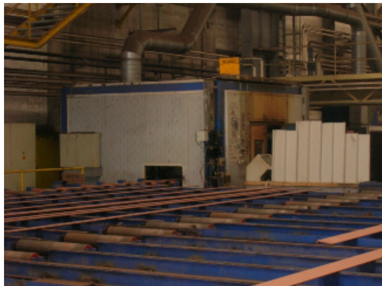
Slika 28. Robot za rezanje plazmom ili acetilen-kisikom u zasebnoj kućici (vidi se i cijev za ventilaciju isključivo tog prostora)
