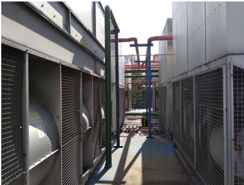
Slika 4. Evaporativni kondenzatori
