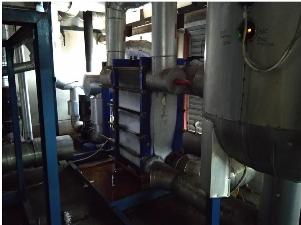
Slika 6. Pločasti izmjenjivači topline
