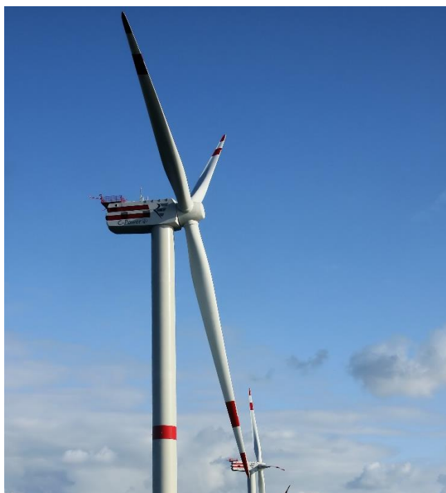
Slika 2. Prikaz vjetroagregata s horizontalnom osi vrtnje
