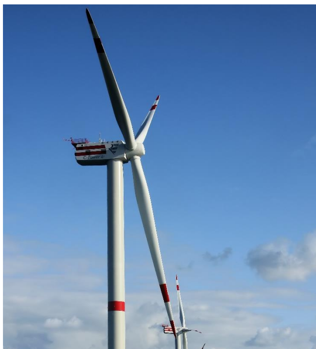
Slika 2. Prikaz vjetroagregata s horizontalnom osi vrtnje
