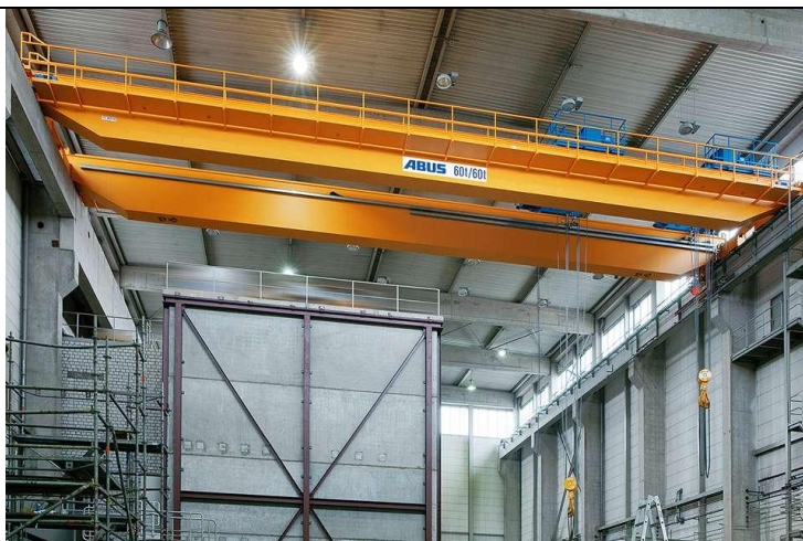
Slika 4. Mosni granik nosivosti 60 tona [5]
