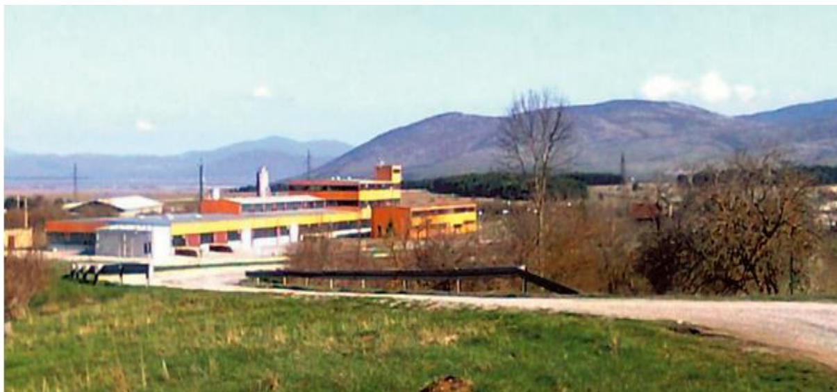
Slika 1. Kogeneracijsko postrojenje na šumsku biomasu u Udbini [2]
