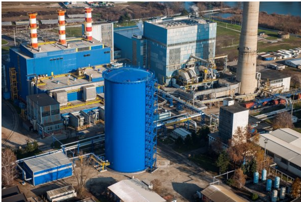
Slika 14. Akumulator topline TE-TO Zagreb [8]
