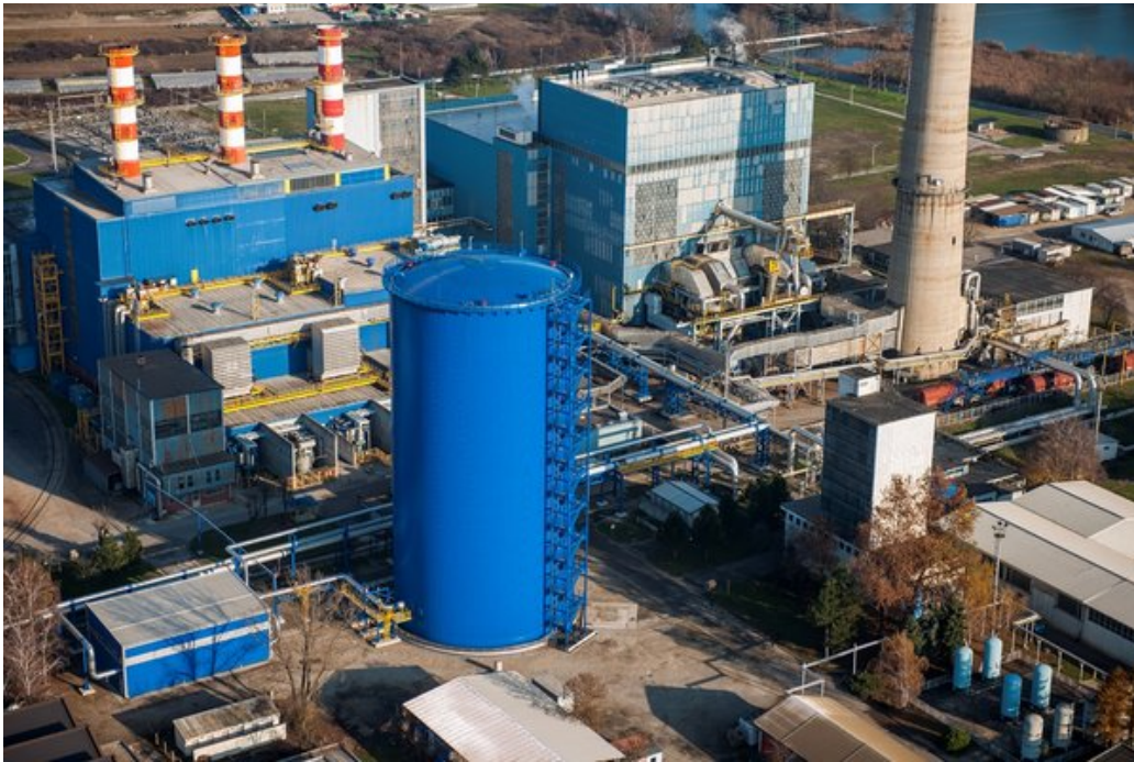
Slika 14. Akumulator topline TE-TO Zagreb [8]
