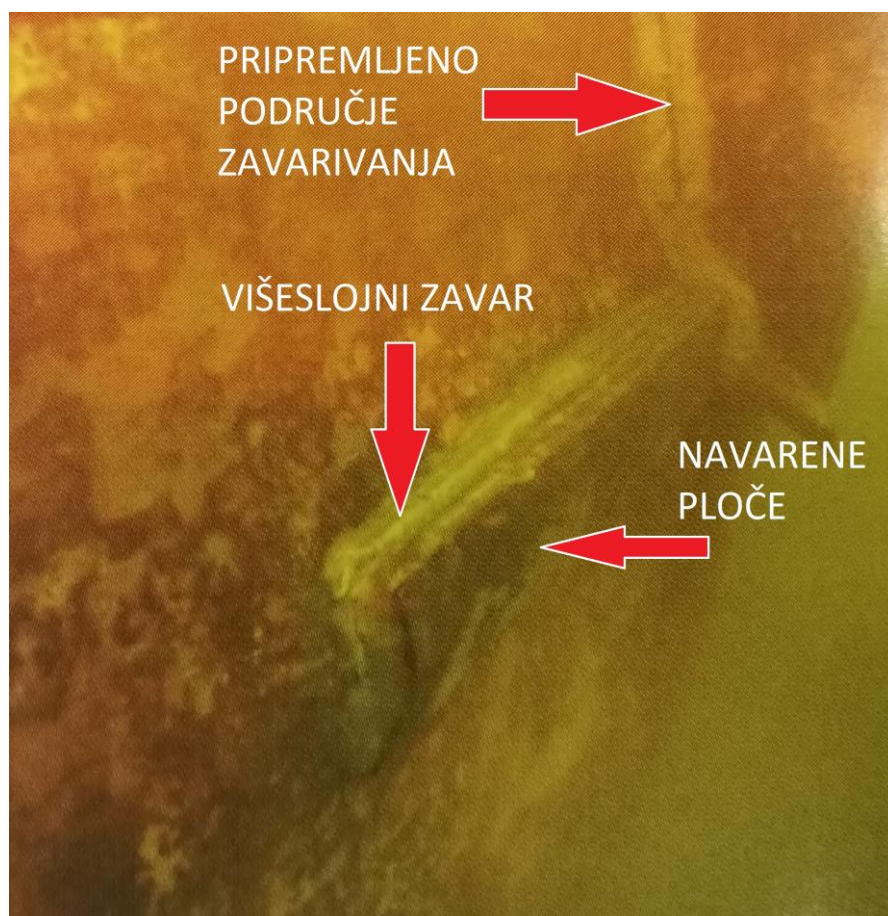
Slika 27. Stanje nakon izvršenih popravaka [15]
