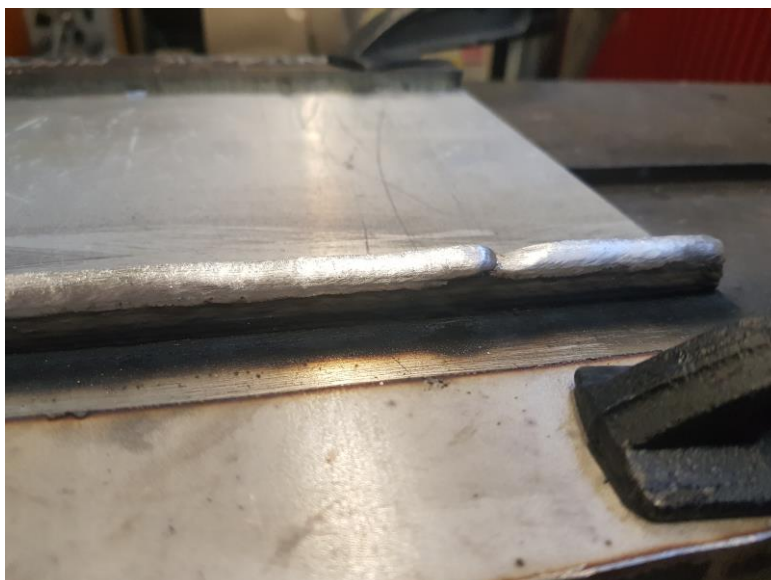
Slika 30. Nepravilnost zavora pri izradi zida 1
