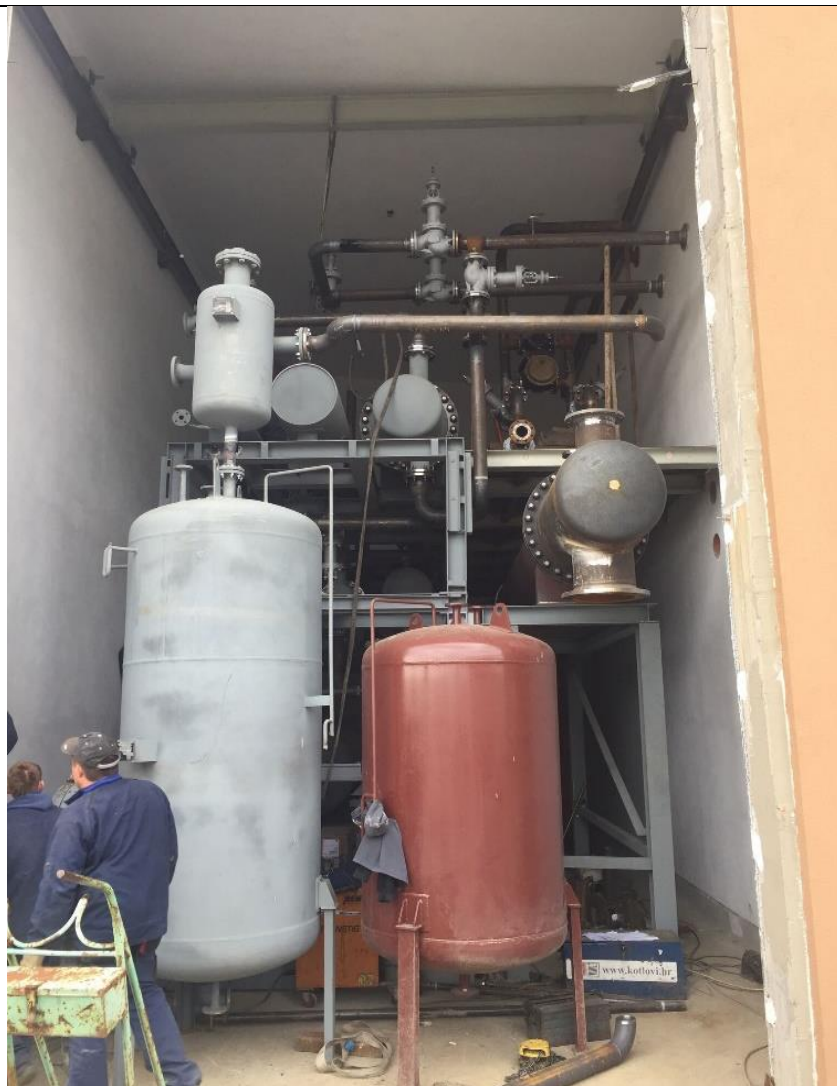
Slika 12. ORC modul referentnog postrojenja prilikom montaže
