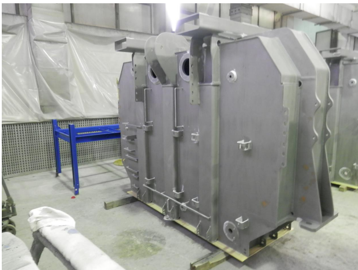
Slika 10. Kućište transformatora nakon pjeskarenja u tvrtci Midi d.o.o.
