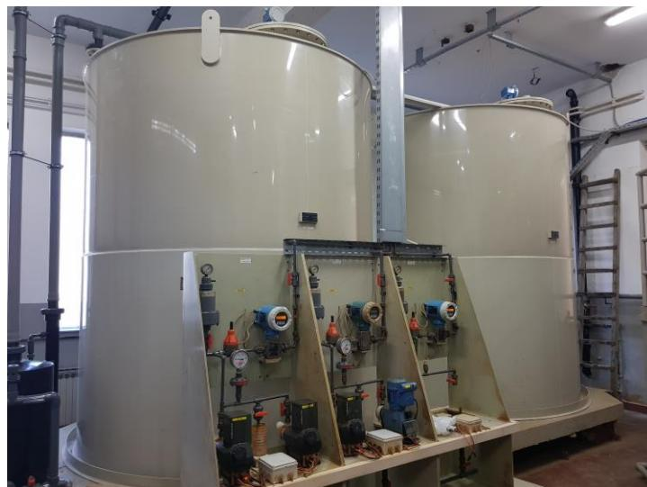
**Slika 5.8 Sustav za doziranje flokulanta PAA**
