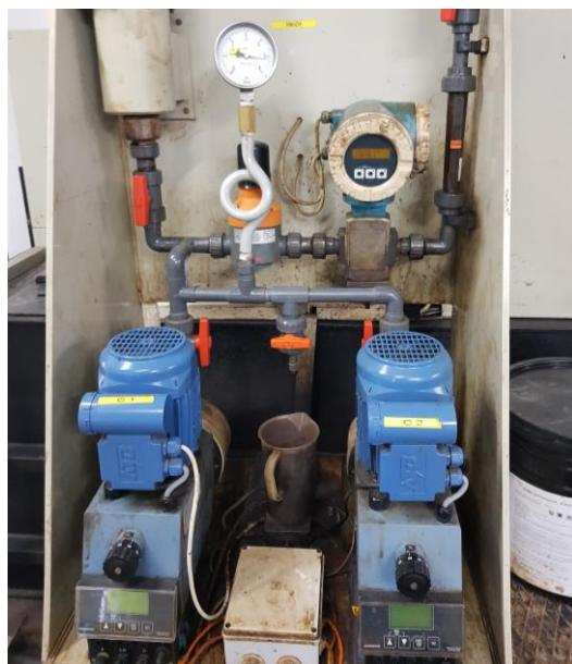
Slika 5.6 Sustav za doziranje kalijeva permanganata
