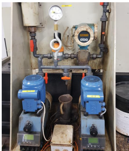
Slika 5.6 Sustav za doziranje kalijeva permanganata
