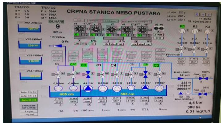
Slika 5.12 SCADA sustav za nadzor i prikupljanje podataka
