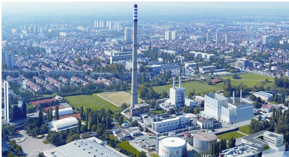
Slika 1.2 Kogeneracijsko postrojenje EL-TO u Zagrebu, primjer daljinskog grijanja
