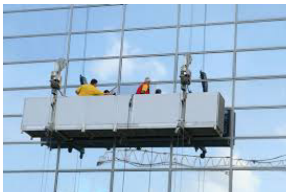
Slika 1. Platformsko čišćenje prozora
