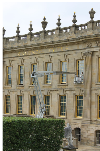
Slika 3. Čišćenje pomoću robotske ruke
