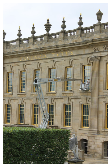
Slika 3. Čišćenje pomoću robotske ruke
