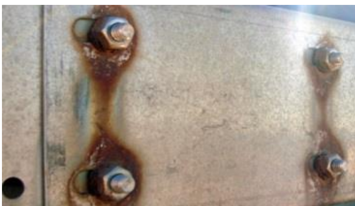
Slika 3. Galvanska korozija
