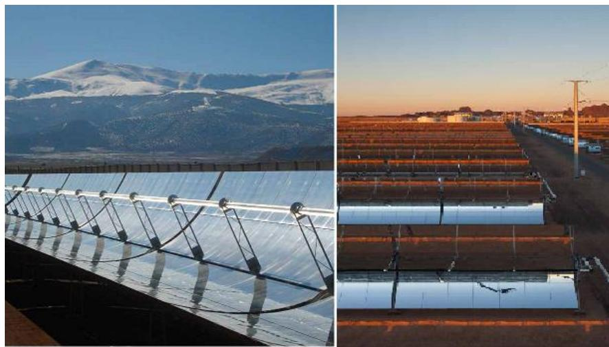
Slika 22. Parabolični žljebasti kolektori [9]
