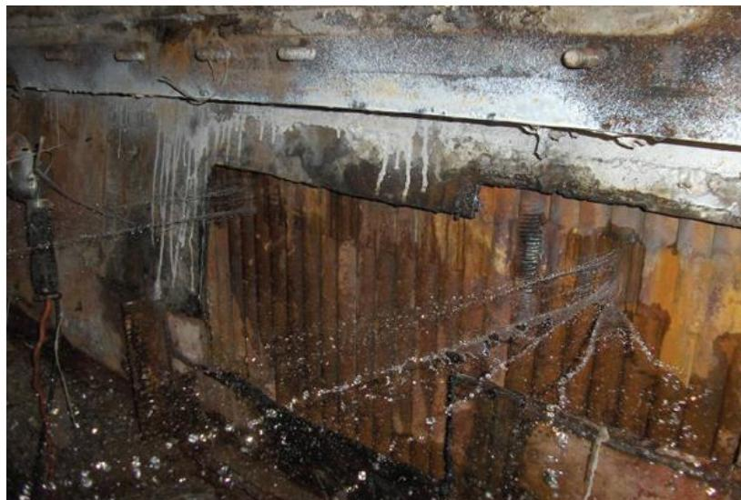
**Slika 6: Propuštanje na spoju cijevi i kolektora uzrokovan temparaturnom ekspanzijom [7]**
