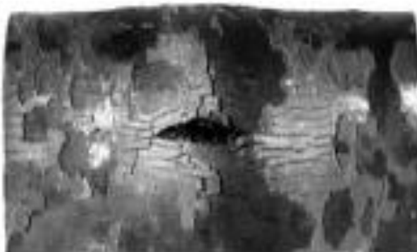
Slika 8 Pukotina kod vremenski duže izloženosti visokim temperaturama i tlakovima [10]
