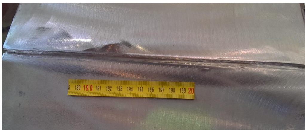
Slika 27. Izrezan (pobrušen) zavareni spoj sa strane korijena
