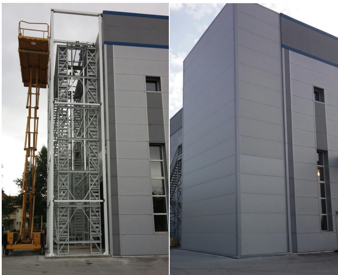
Slika 12. Izvedba VLM sustava kao samonosive jedinice [3]
