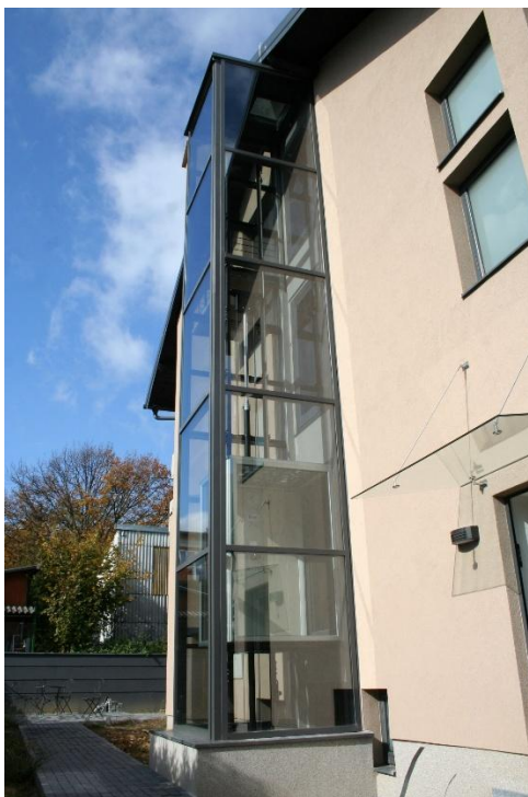
Slika 18 Prikaz oslonjenog fasadnog dizala sa staklenom ispunom
