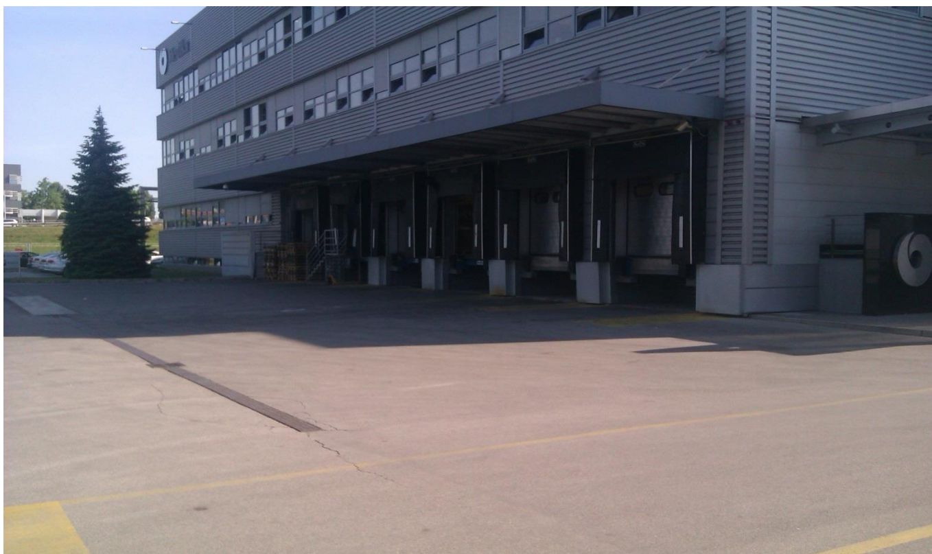
Slika 4.4. Vanjska strana prijemne zone
