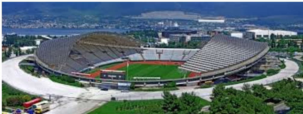
Slika 3: Primjeri klase izvedbe EXC3 [9,10,11]
