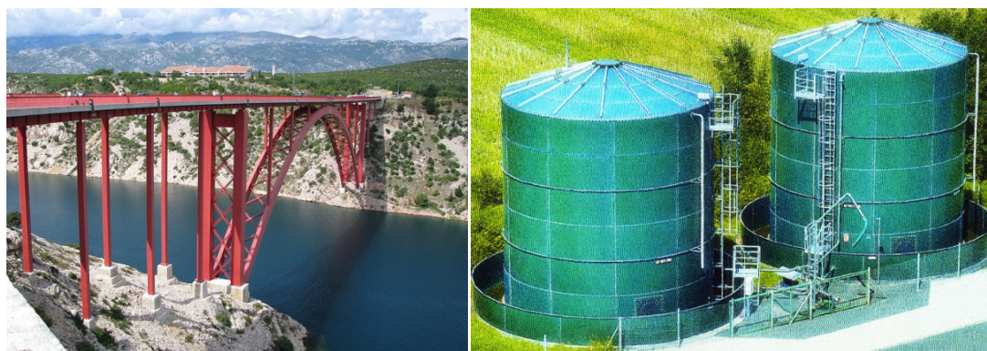
Slika 4: Primjeri klase izvedbe EXC4 [12,13]
