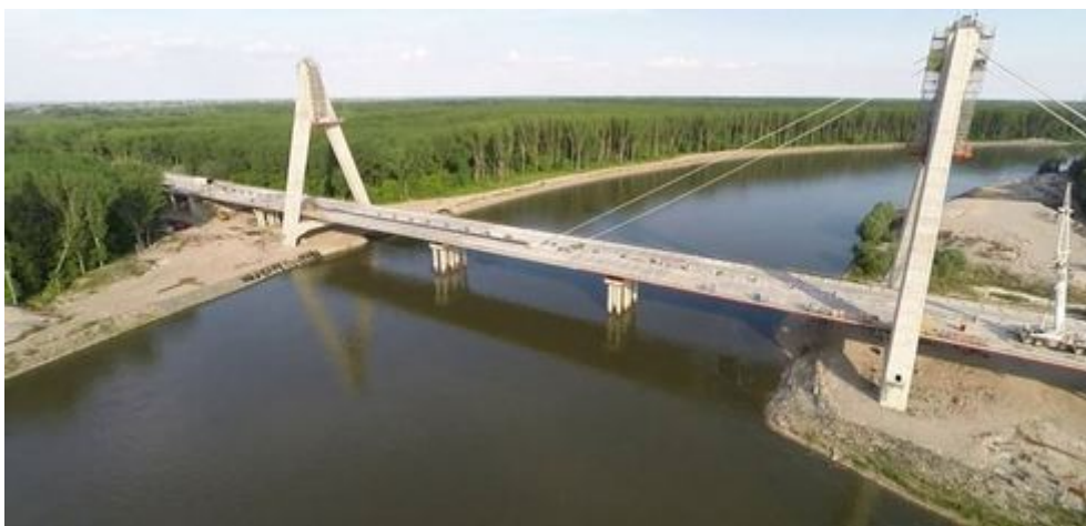
Slika 12: Most Drava u izgradnji [25]
