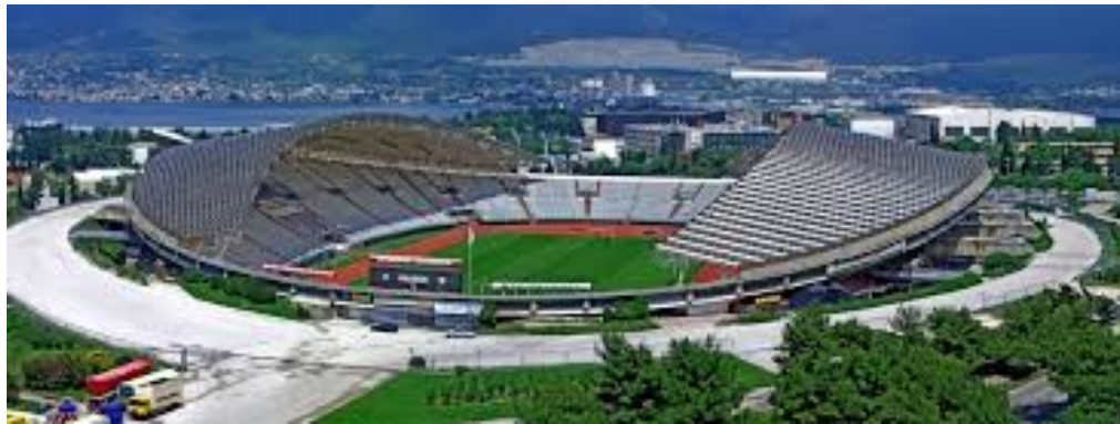
Slika 3: Primjeri klase izvedbe EXC3 [9,10,11]
