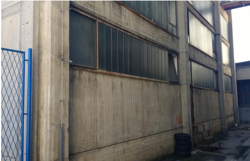
Slika 5.5 Trenutni izgled prozora zapadnog zida za smještaj ventilacije ispitne kabine
