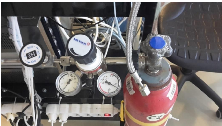
Slika 30. Spremnik i ventili za otpuštanje vodika
