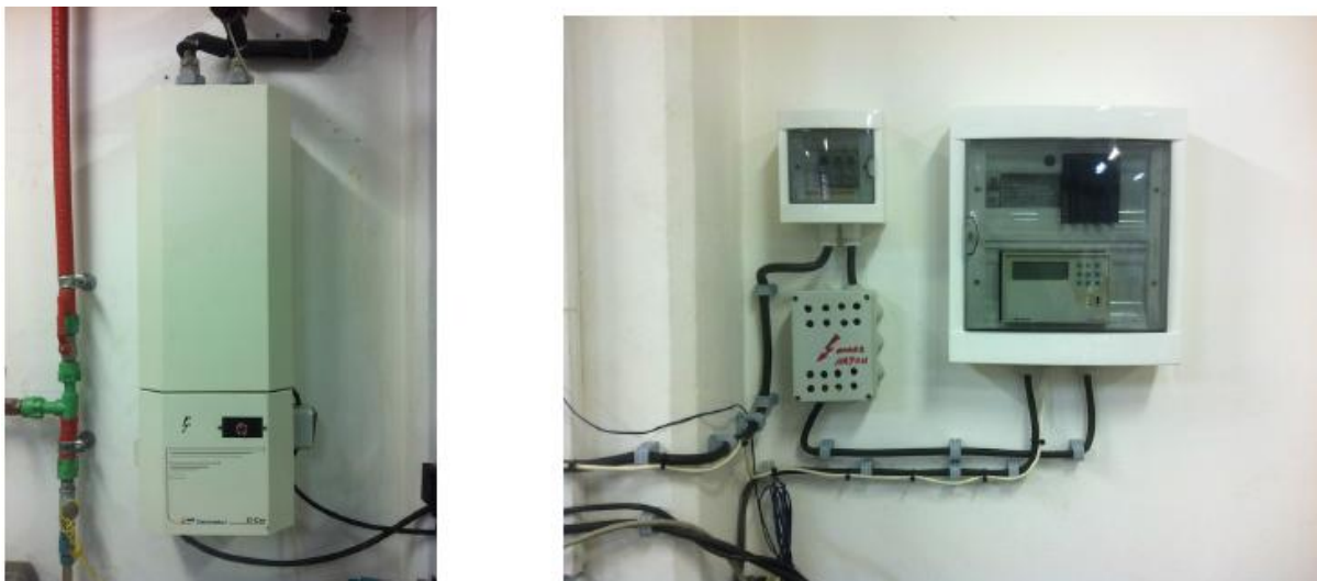
Slika 28 Električni grijač s regulatorom
