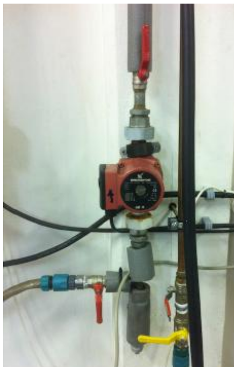
Slika 27 – Cirkulacijska pumpa kruga grijanja
