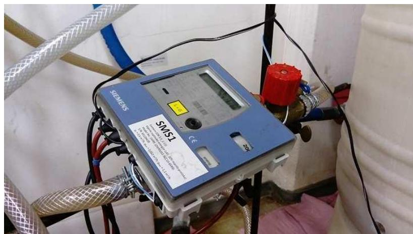
Slika 34 – Ultrazvučni protokomjer
