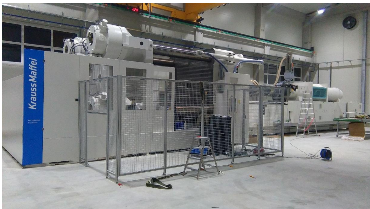
Slika 46. Montaža ograde i postolja
