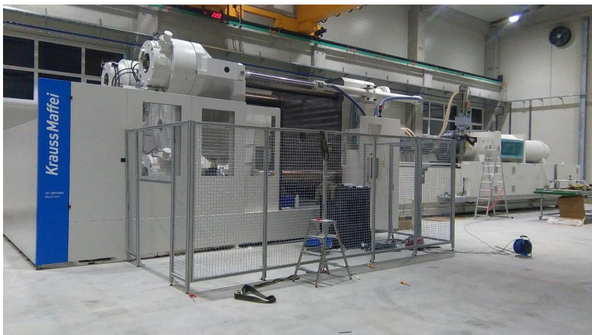
Slika 46. Montaža ograde i postolja
